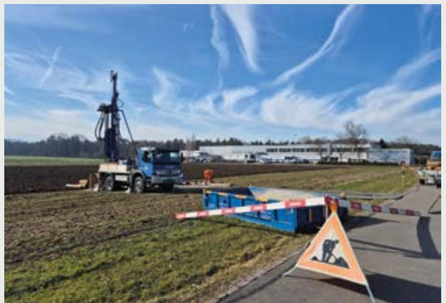
Sondierbohrungen auf dem Baugrund im Auholz/Langstuude in Sulgen.
